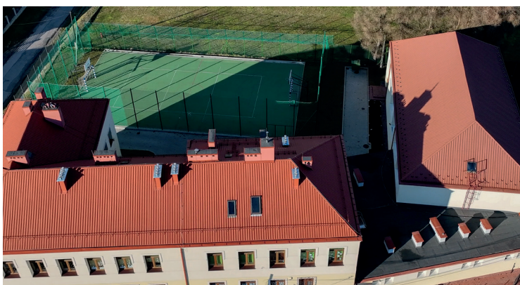
Termomodernizacja szkoły we Włosani (wraz z boiskiem)
