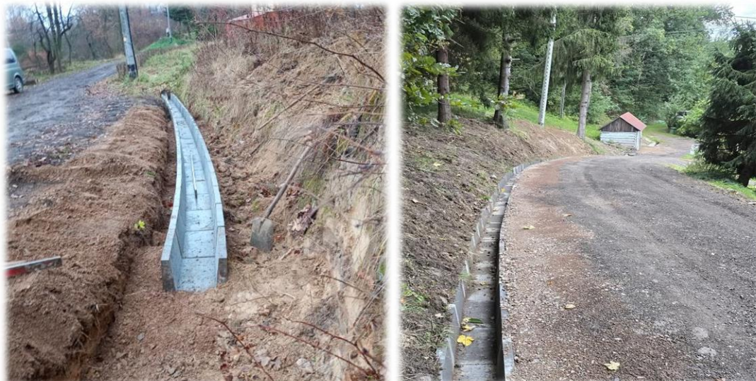
Gaj ul. Pod Górą – ułożenie korytek odwadniających i utwardzenie pobocza
