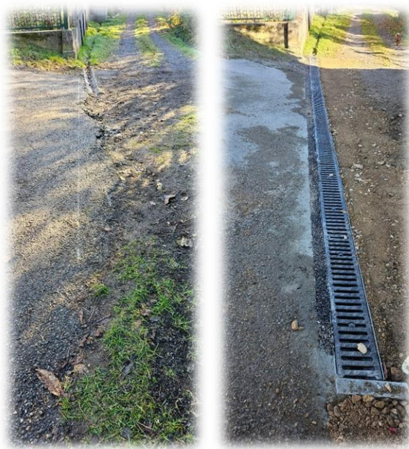
Mogilany ul. Mogilańska wykonanie odwodnienia liniowego akodren
