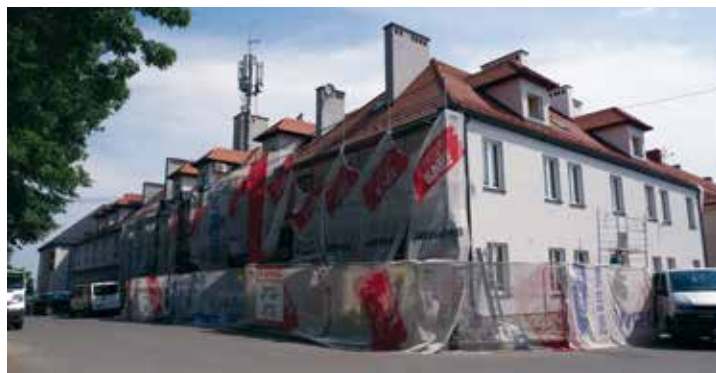
Termomodernizacja Urzędu Gminy
